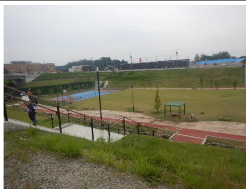
グルービー縦(もみ)の木公園付近の谷地形
